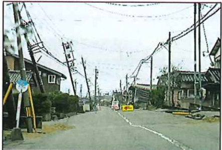
ゆるく堆積した砂の地盤、埋立地等に強い地震動が加わると、地層自体が液体状になる現象
